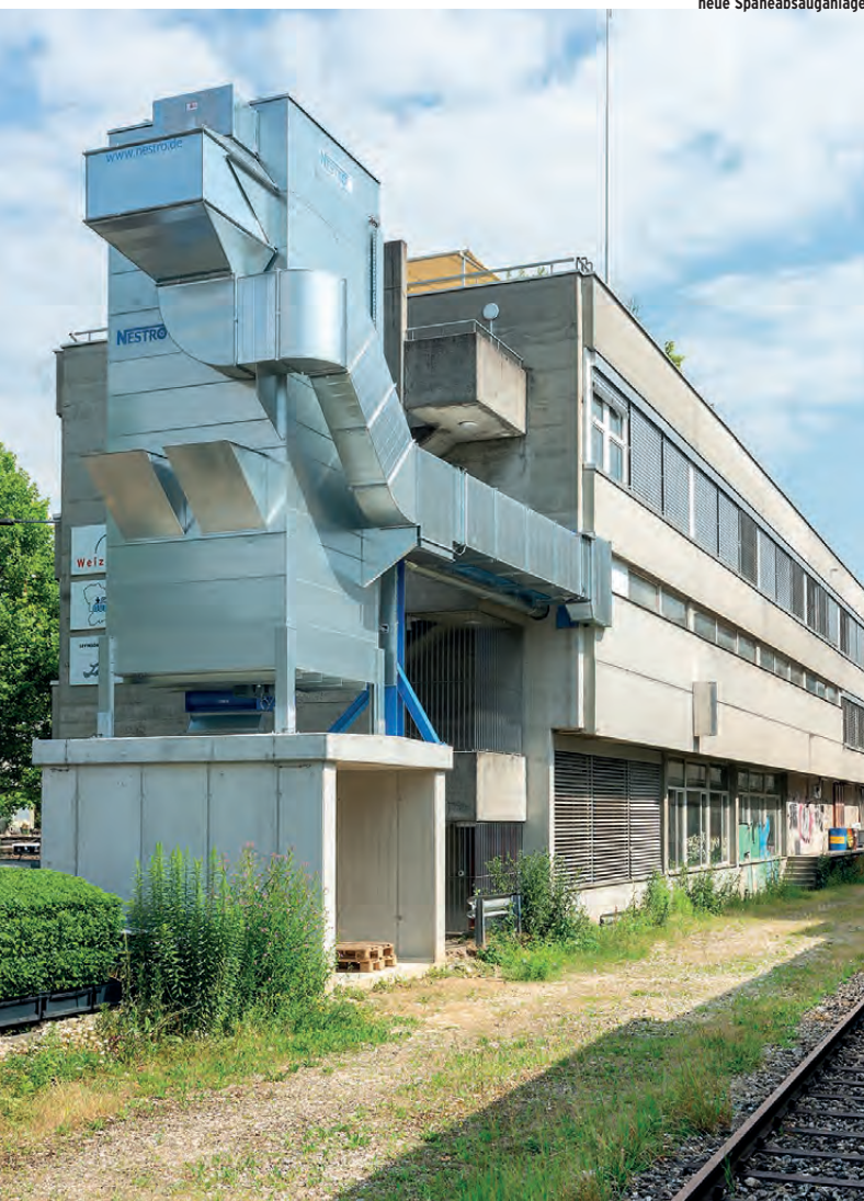
neue Späneabsauganlage
